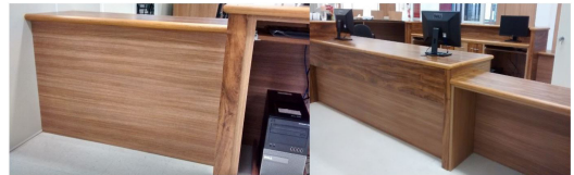
Figura 6. Vista interna e externa da adequação da extremidade esquerda do balcão. Fonte: As autoras (2015).
